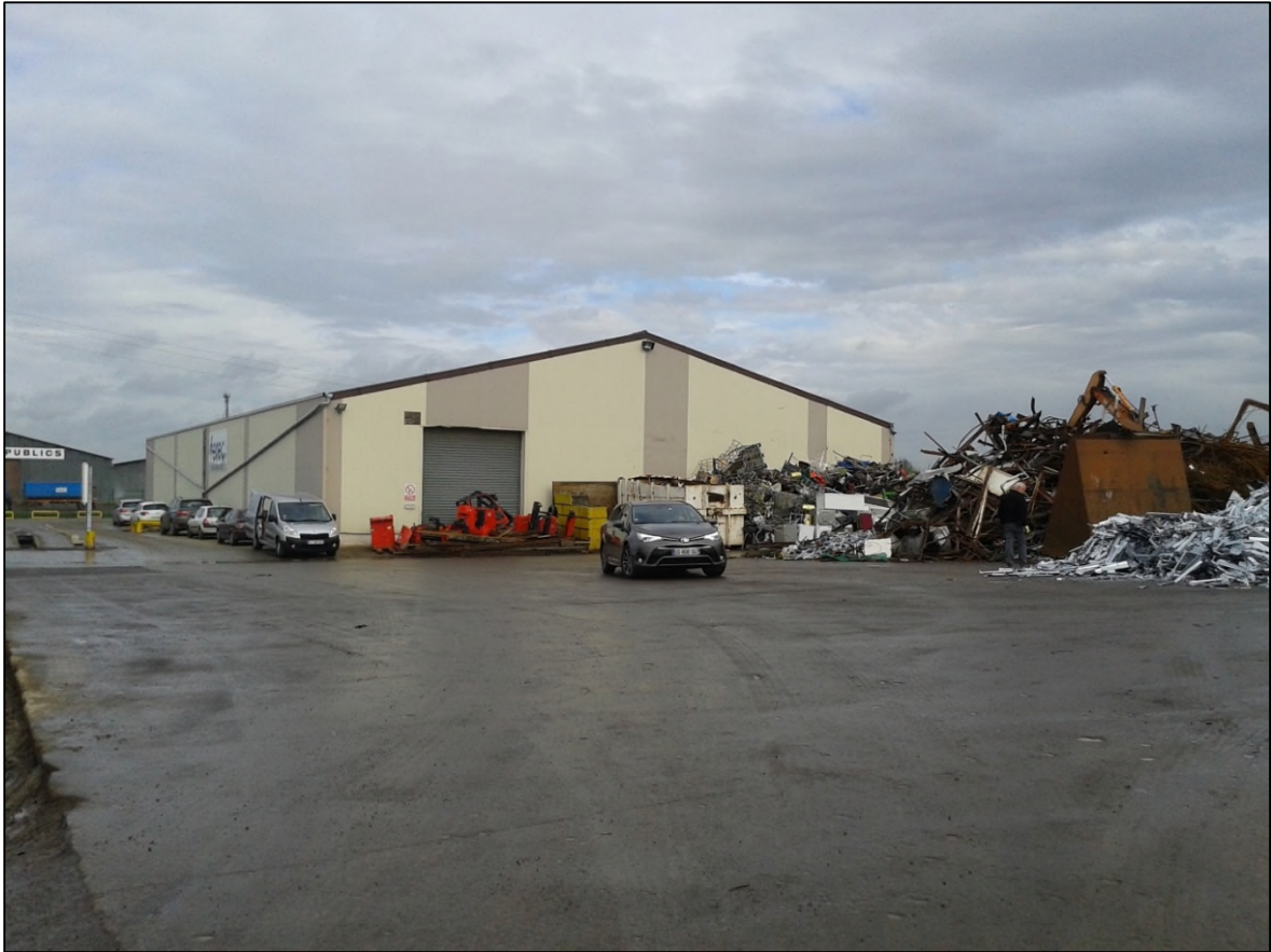
Bâtiment et plateforme actuellement exploités
